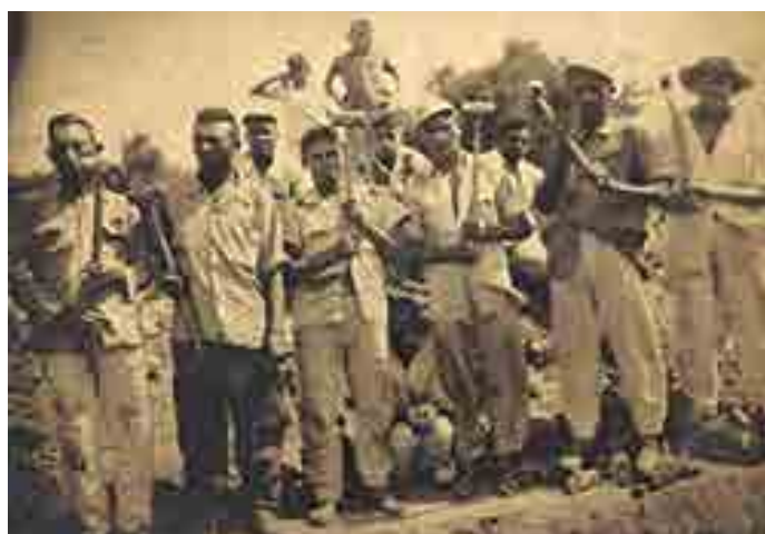
Operários trabalhando na construção do Açude de Boqueirão (1954)
